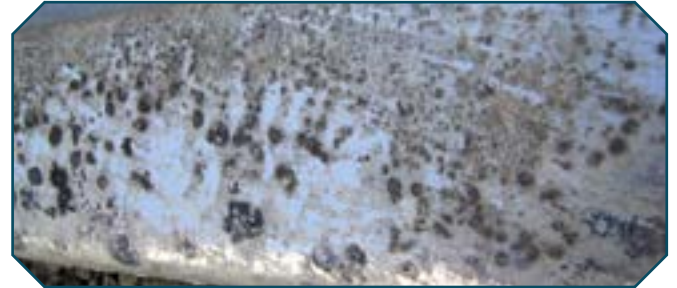
Ilustración 10: Mancha de oxidación por almacenamiento extrema
