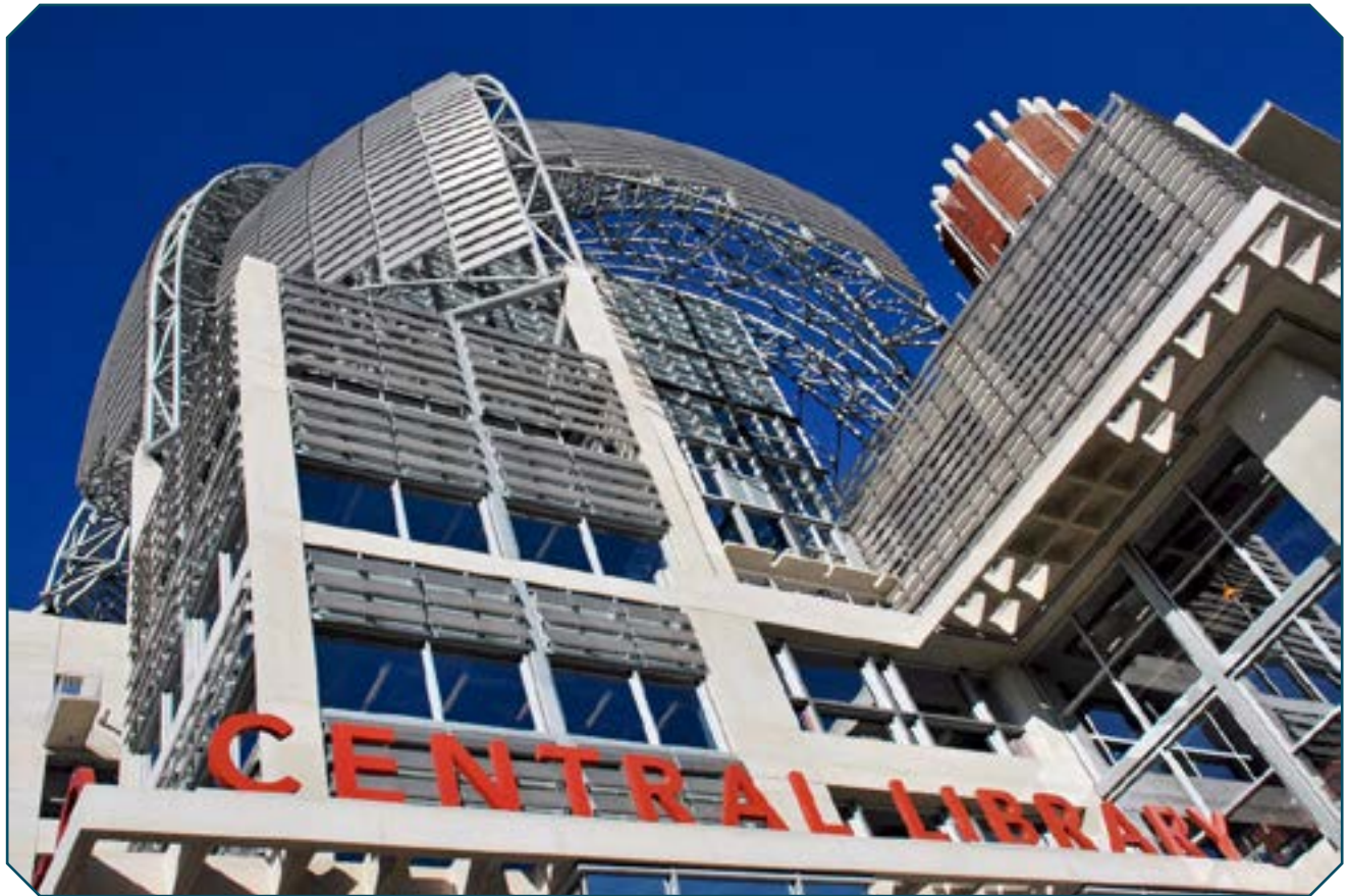
La San Diego Central Library emplea acero galvanizado
