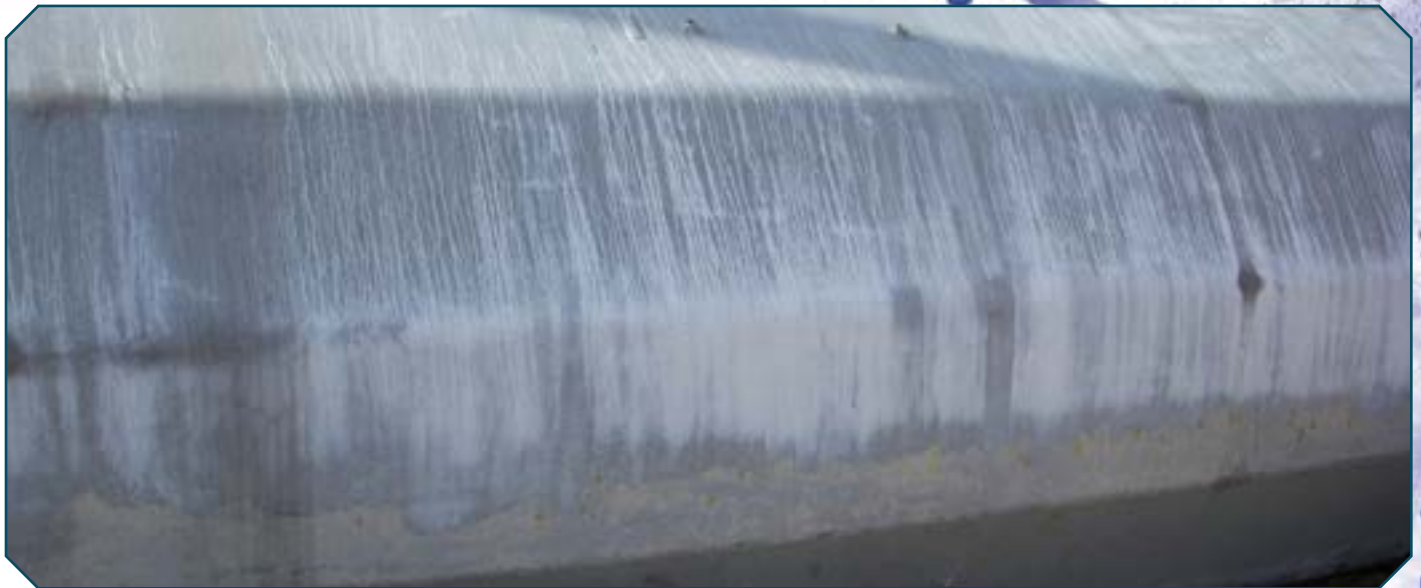
Ilustración 1: Mancha de oxidación por almacenamiento
