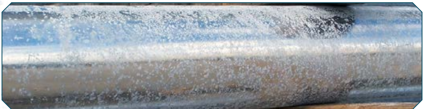
Ilustración 4: Almacenamiento inadecuado de acero galvanizado: anidado
